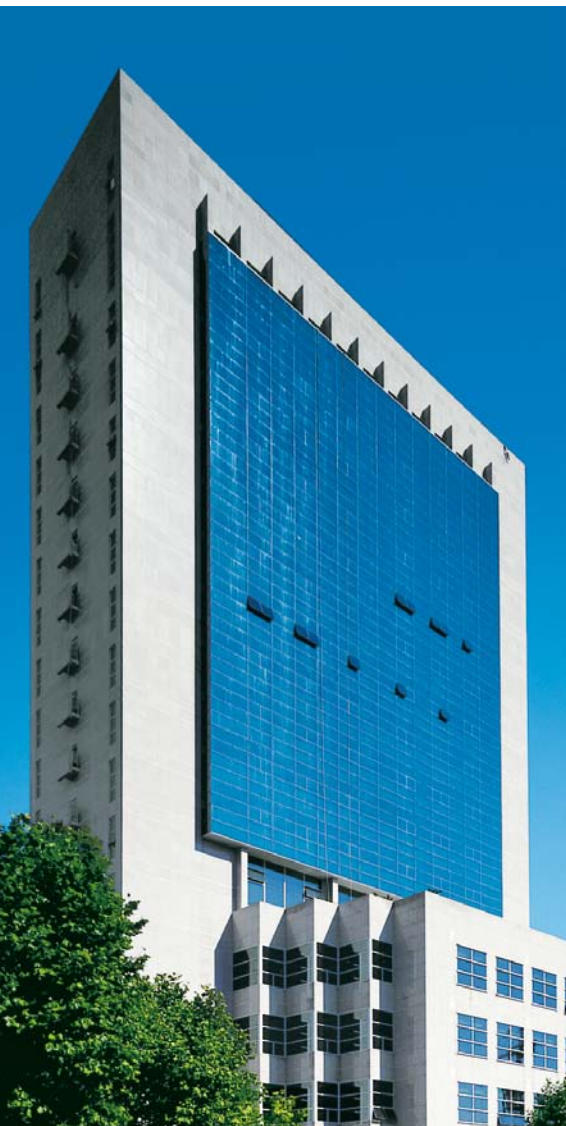
Complejo Inmobiliario Samsung Boramae, Seul, Corea del Sur Samsung Boramae Complex Building, Seoul, South Korea
